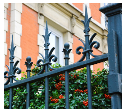
PINTURA DE GRADES
